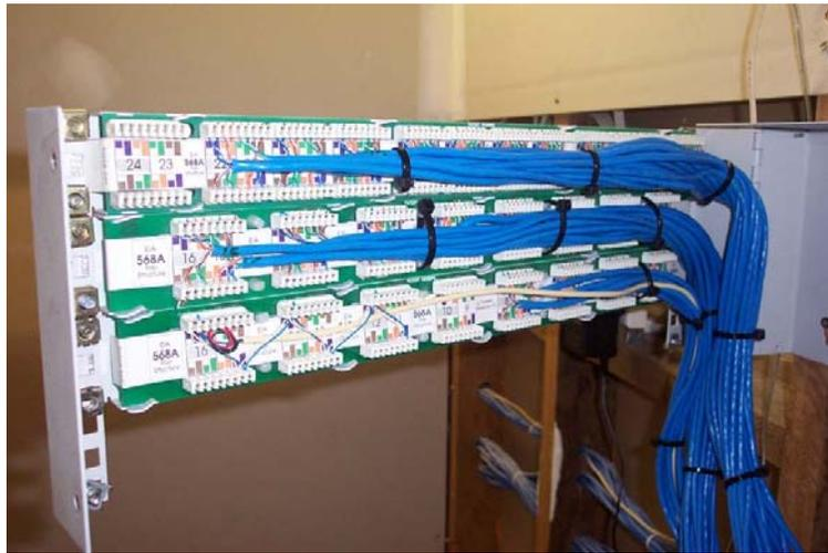
**Paso 5: Pruebe las terminaciones del panel de conexión y el jack de datos con un analizador de cables básico (opcional)**
