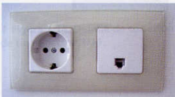
↑ Figura 1.26. Toma telefónica empotrable en una instalación doméstica.
