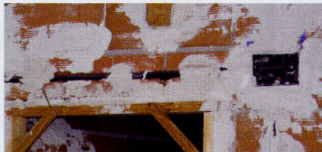
↑ Figura 1.57. Detalle del montaje de una instalación empotrada.
